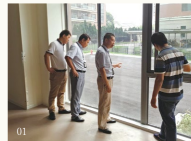
01 项目实地检查
