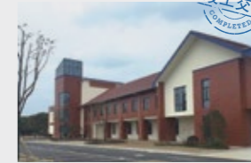
阳澄湖半岛公安、城管、水上执法综合用房改建
